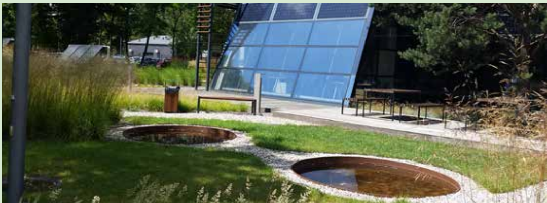
Gromadzenie wód deszczowych z dachu, szutrowe, przepuszczalne ścieżki spacerowe Sammlung von Regenwasser vom Dach, durchlässige Fußwege aus Kies
