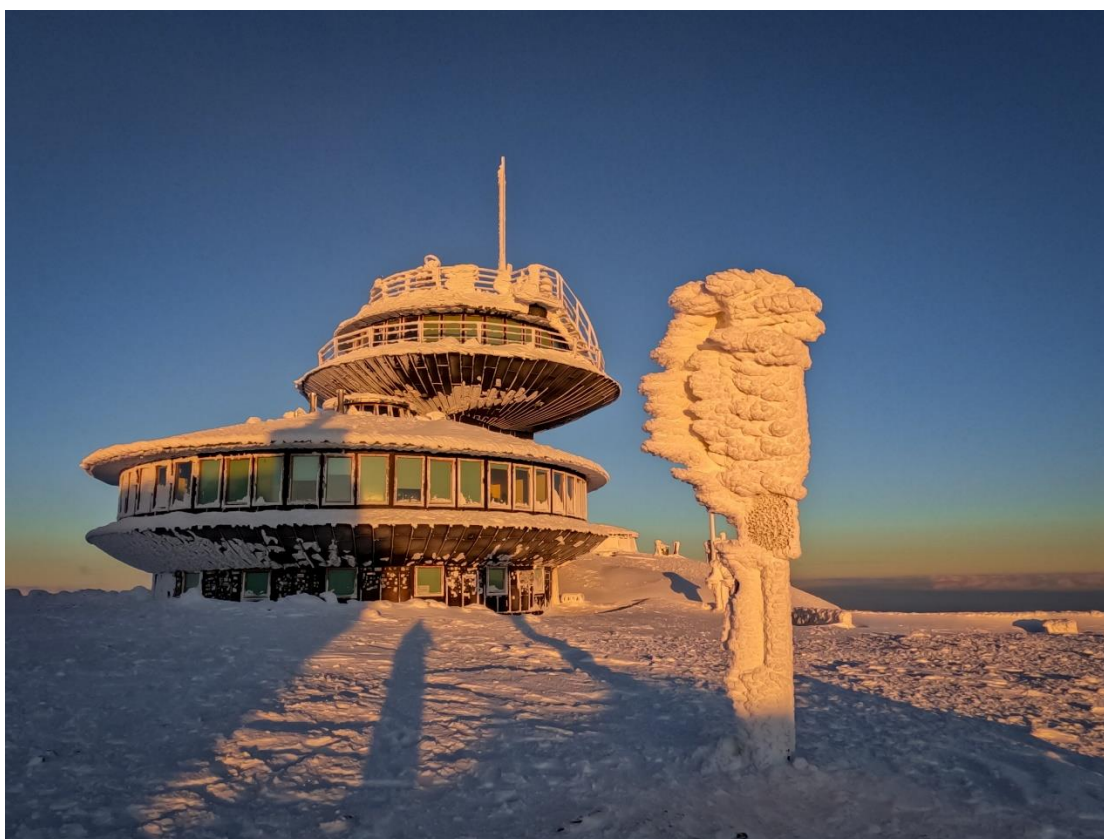
Grudniowy wschód słońca na Śnieżce i Wysokogórskie Obserwatorium Meteorologiczne IMGW-PIB na Śnieżce, 09.12.2022 r. Fot. Piotr Olszewski | IMGW-PIB
