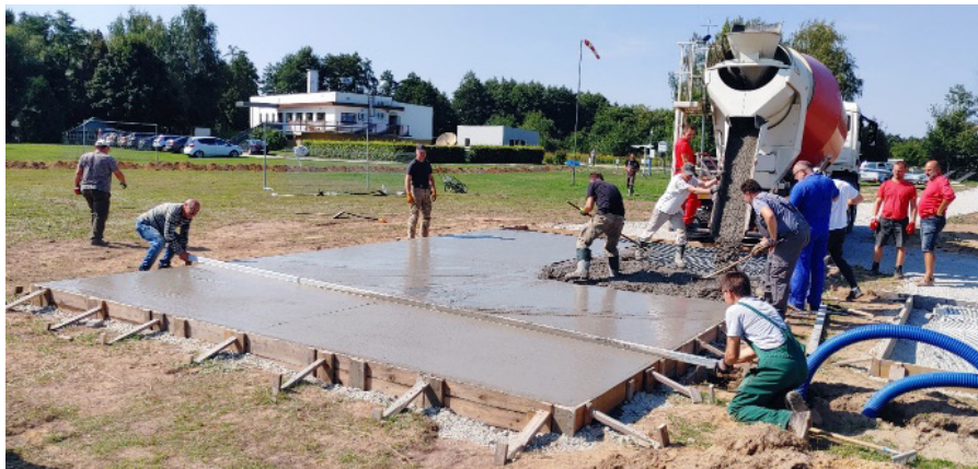
Fundament pod stację aerologiczną we Wrocławiu.
