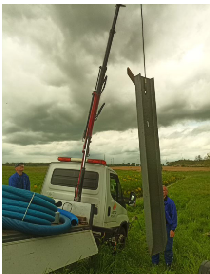
Budowa stacji Głuszycko.
