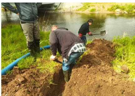
Budowa stacji Damno.
