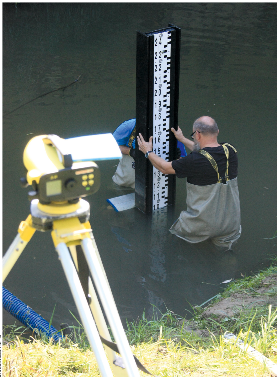
Budowa stacji hydrologicznej – ustawienie wodowskazu.
