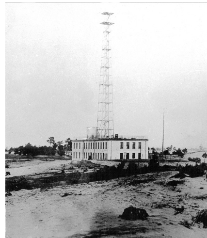
Gmach Obserwatorium Aerologicznego z żelazną wieżą obserwacyjną (zdjęcie z 1938 roku, archiwum IMGW-PIB).
