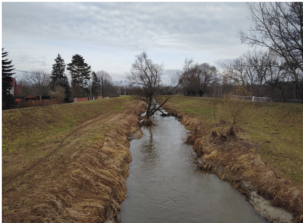
Rys. 2.3. Przekształcone koryto rzeki Rudawa w Krakowie. Fot. T. Walczykiewicz.
