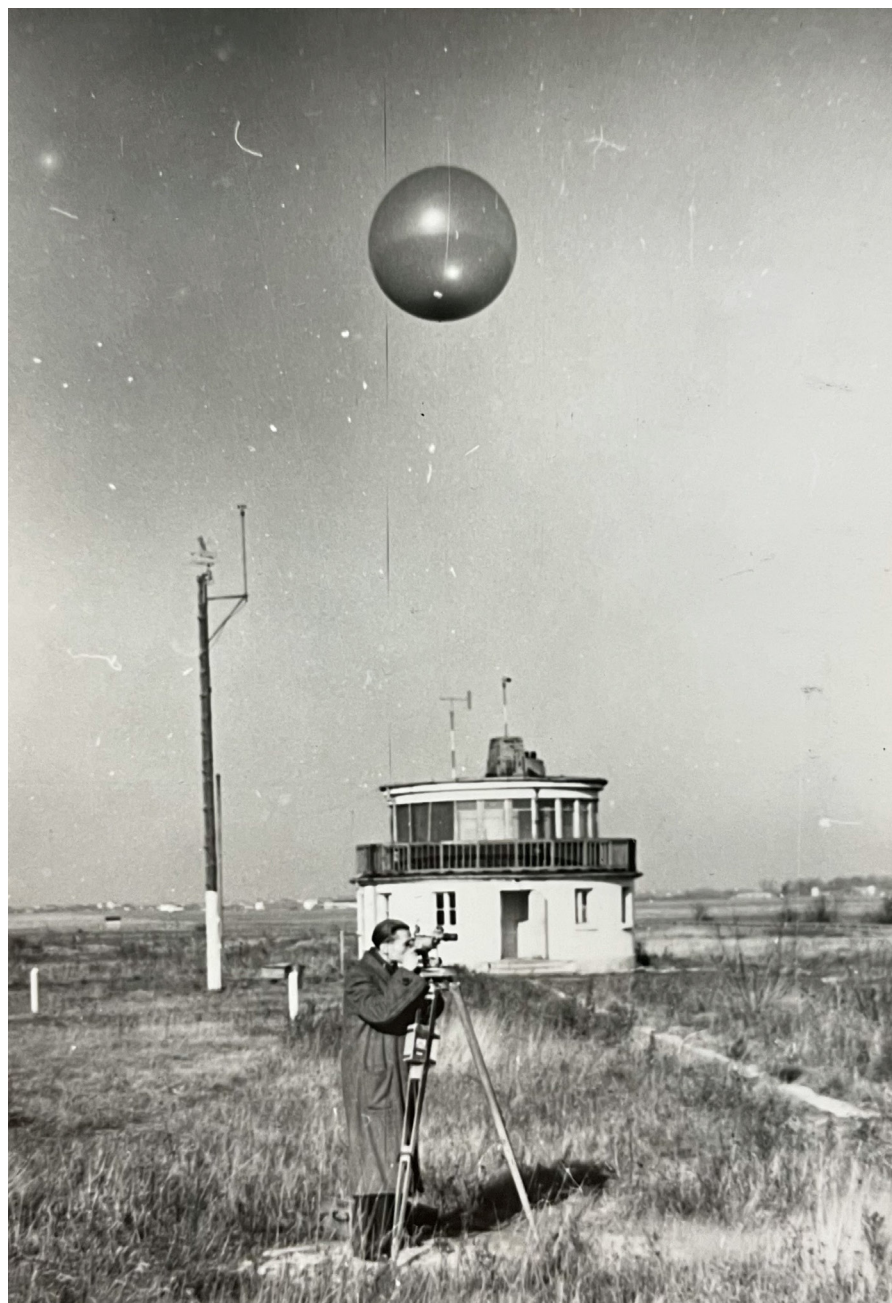
Informator podczas pomiaru górnych wiatrów przy pomocy teodolitu na tle budynku „Goniometr” (źródło: archiwum LSM Warszawa).
