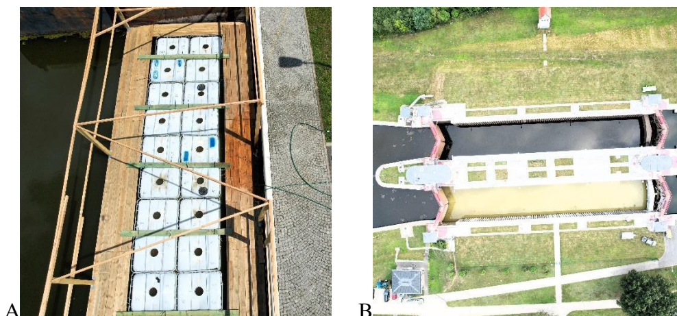
Rycina 1. Fotografie przedstawiające stanowiska badawcze: Fot. A – etap 1 śluza Sławęcice; Fot. B – 2 etap, śluza Rudziniec.
