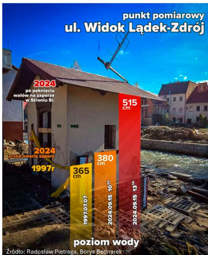
Fot. 4. Prezentacja odnotowanych stanów wody w lipcu 1997 r, wrześniu 2024 r. i po przejściu katastrofalnej fali z przerwanego zbiornika w Stroniu Śląskim.
