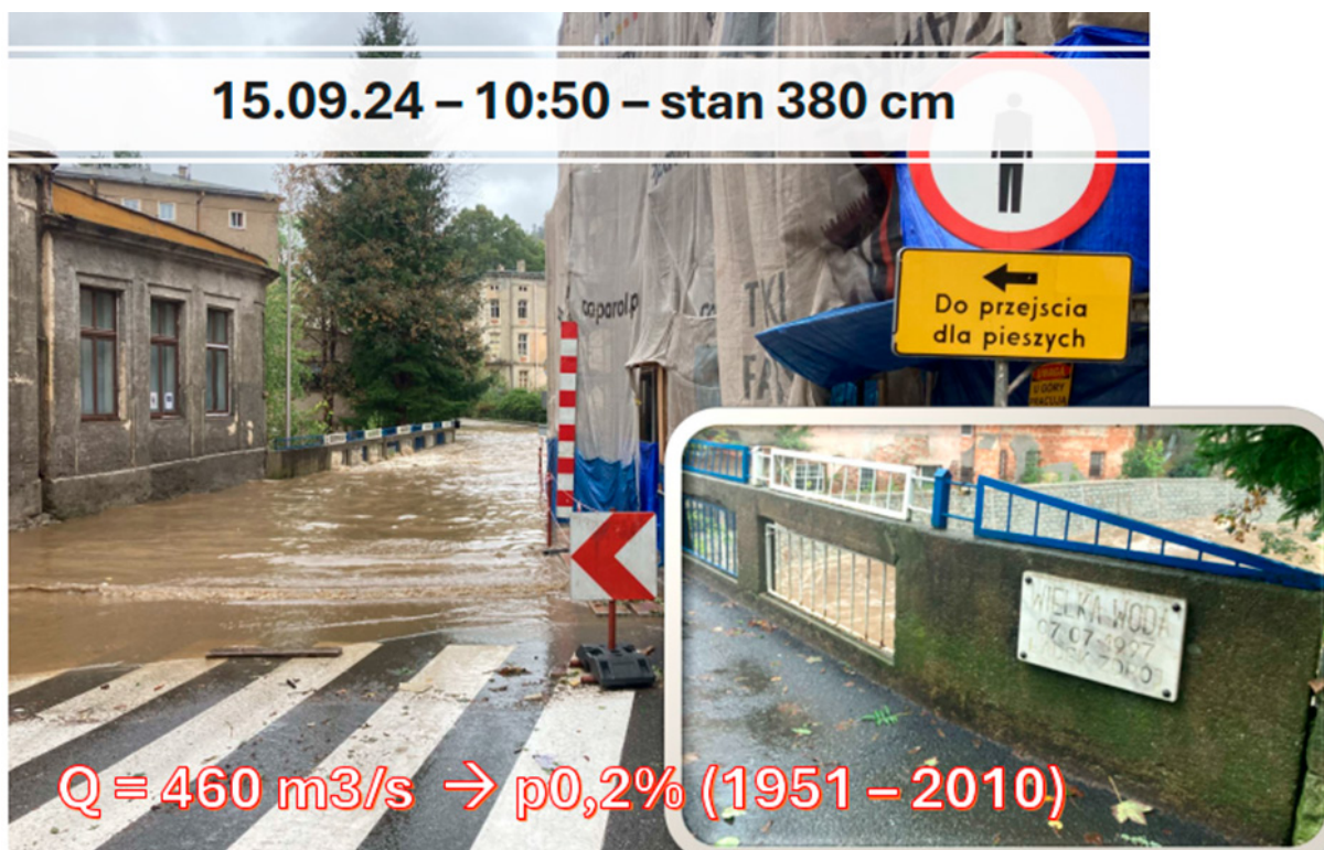
Fot. 2. Przekroczenie poziomu znaku wielkiej wody z 1997 przy przepływie p = 0,2\% (F. Borys Bednarek).
